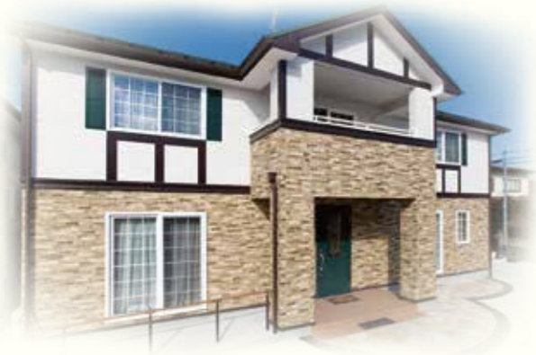
チューダー様式のS様邸。2階外壁のティンバーが個性を放ちながらも周囲の景観と調和している
